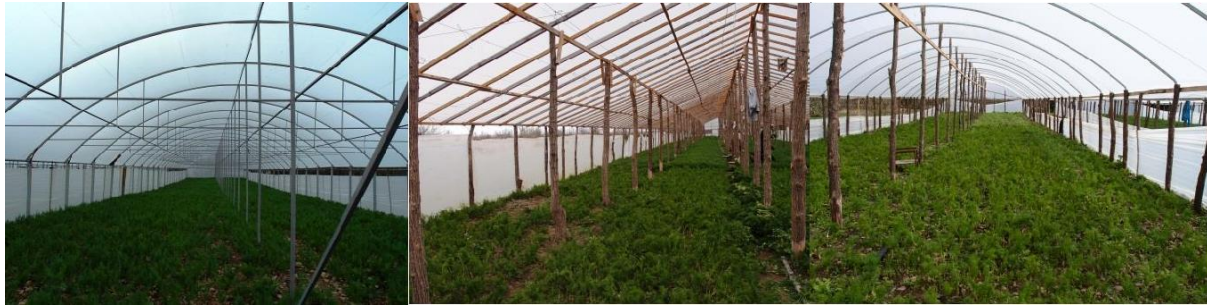
სურათი 4 – რკინის, ხის და კომბინირებული სასათბურე ნაგებობა
